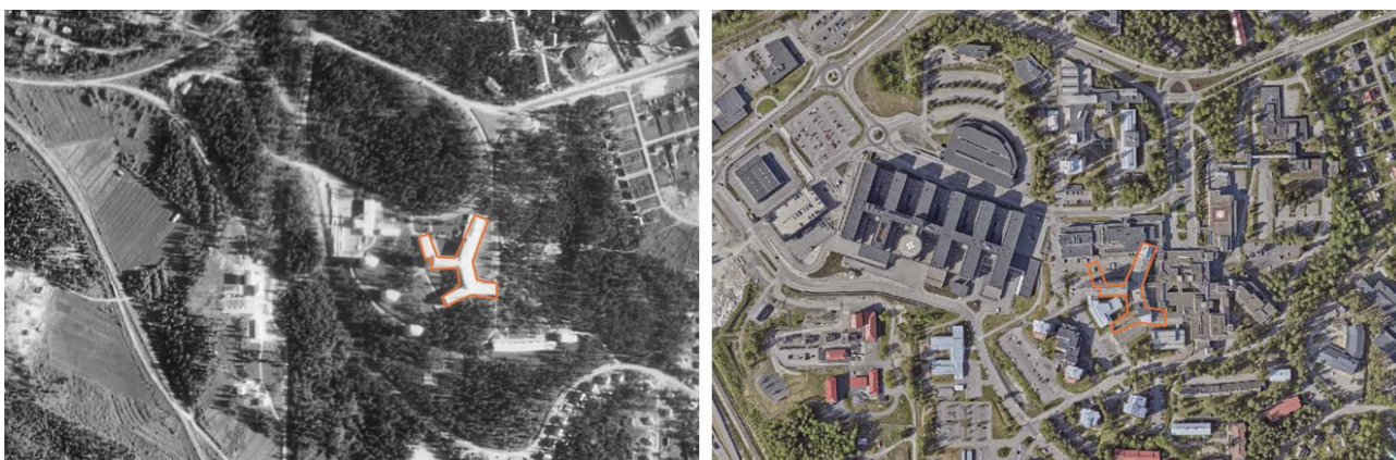
Kuva 20. Ilmakuva vuodelta 1955 ja oikealla ilmakuva 2020-luvulta (Kukkulan alueellinen selvitys ja rakennusinventointi, Sweco 2025). Kuviiin on viitteellisesti oranssilla merkitty päärakennus alkuperäisessä laajuudessaan.
